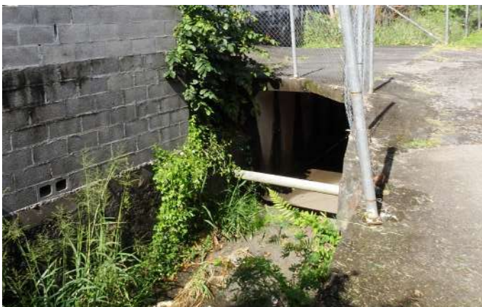
Les caniveaux profonds et bétonnés
