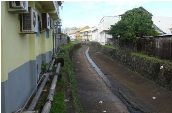
La Ravine Sèche canalisée en coeur de ville
