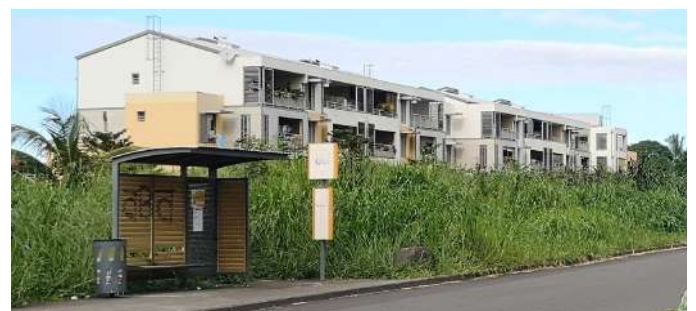
Intégration des principes bioclimatiques : auvent, débord de toit, bardage, brise-soleil
